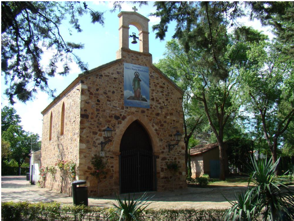
Parroquia de Santa María Magdalena. Exterior. Lado sur. Estado actual.
